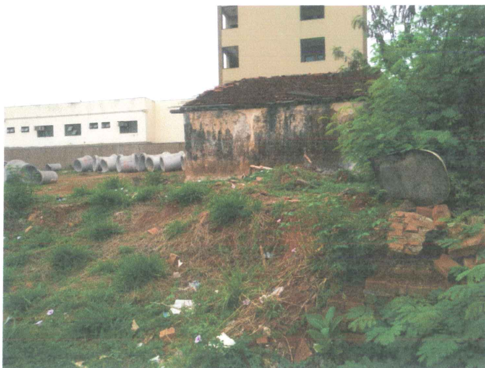
Foto 2: Edificação em Ruínas
