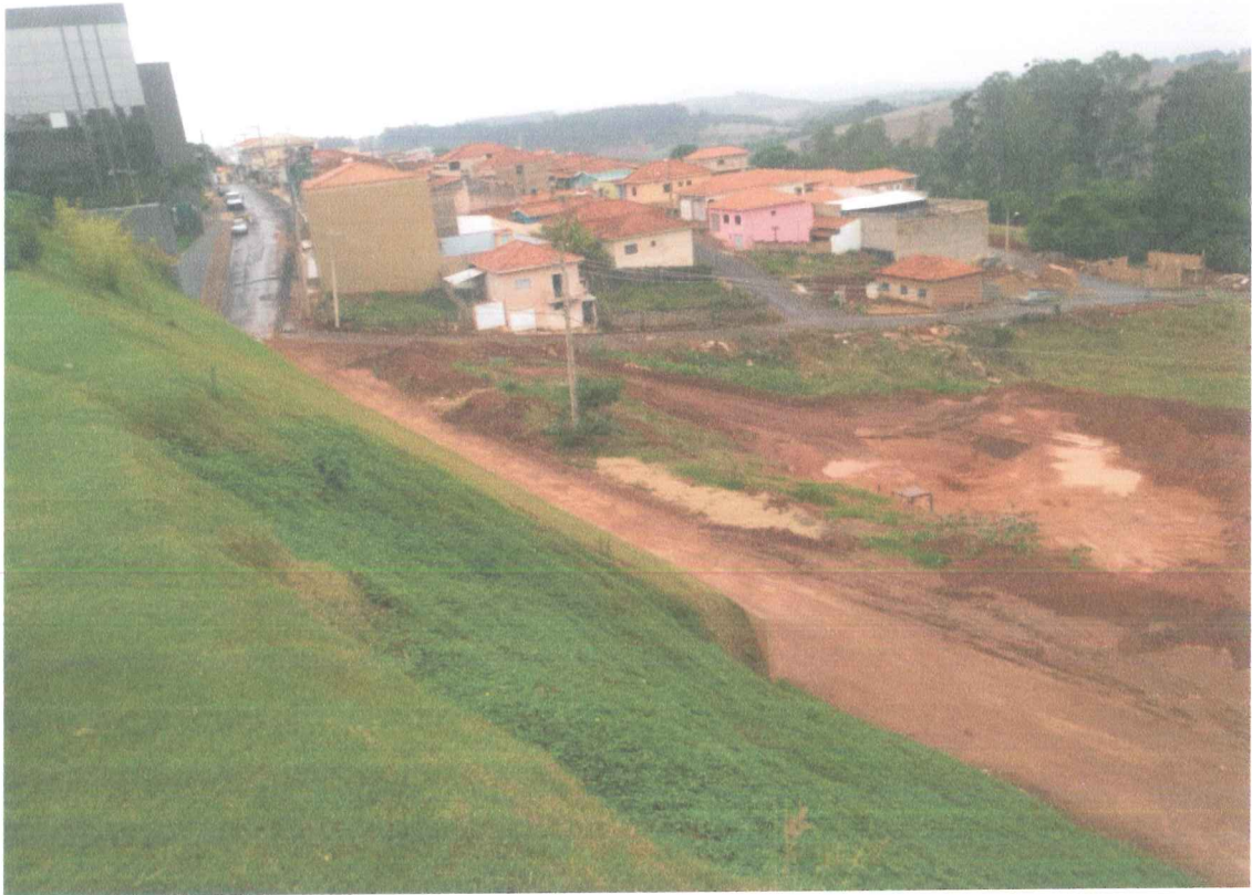
Foto 5: Vista do Lote pelo estacionamento da Empresa Brasil Card
