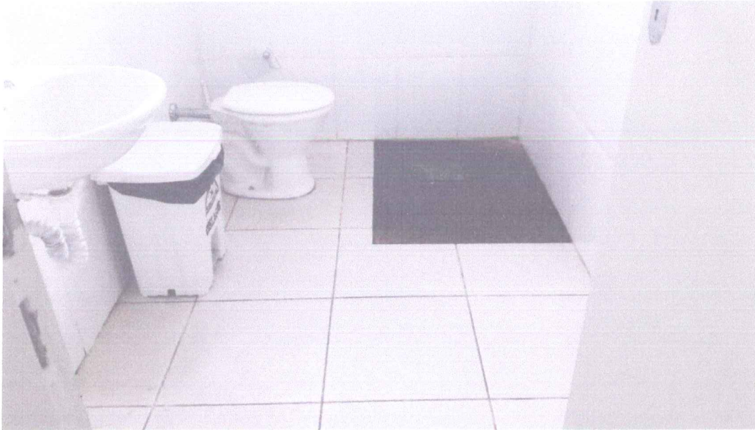
IMAGEM 1 – BANHEIRO DA UNIDADE COM INFILTRAÇÃO E INSTALAÇÕES SANITÁRIAS DANIFICADAS
